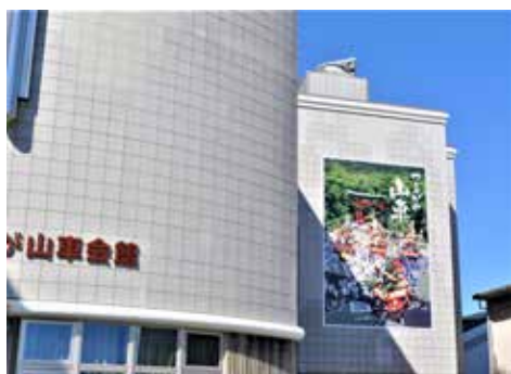
みなとつるが山車会館建物側面に新設置の大型看板
